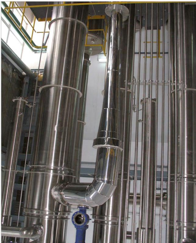
Abb. 3: Verdampferstufe mit TVR (thermal vapour recompression)
